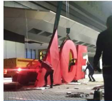
PEMASANGAN LETTER ACE
